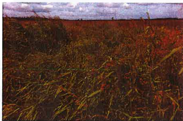
Vue amont des travaux (section 3)
